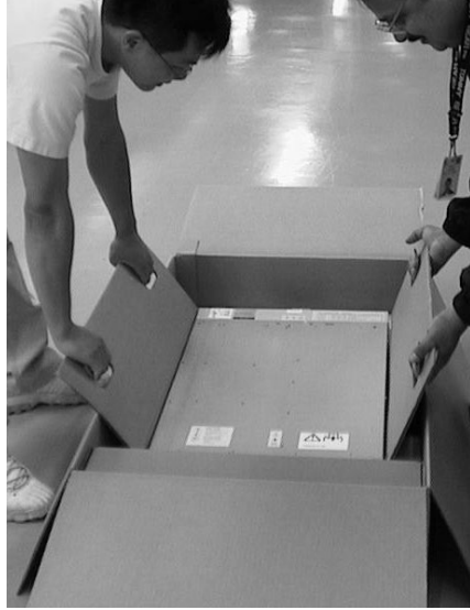
图 20. 打开不间断电源运输纸箱的顶盖
